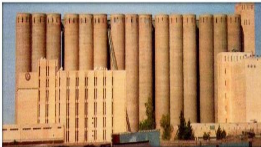
Figure 4 : Photo représente Silos de stockage en biton armé ( Kermiche, 2013 ).
