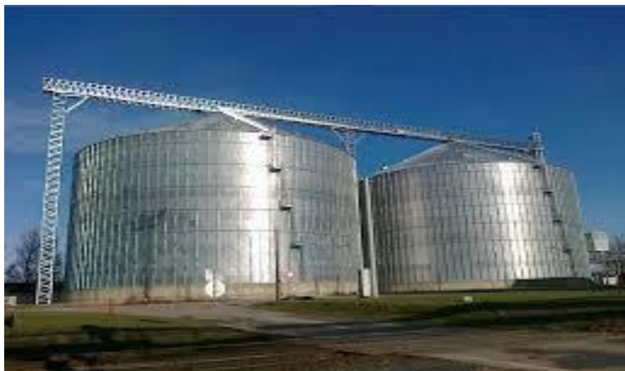
Figure 5 : Photo représente Silos de stockage en métal ( Kermiche, 2013 ).
