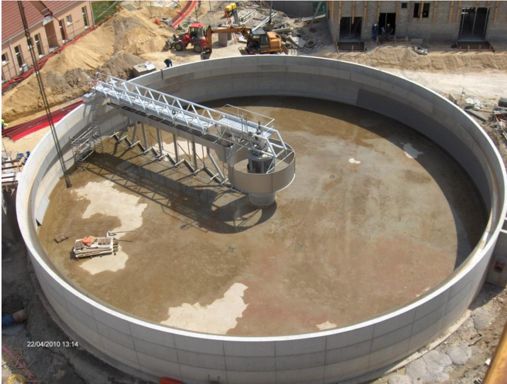
Figure II.2 Décanteur primaire circulaire (Anonyme 2, 2010).
