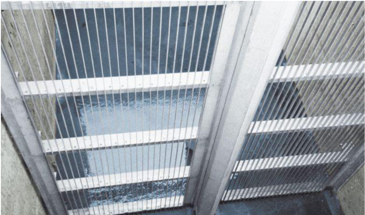
Figure II.1. Dégrilleur manuel (Anonyme 1, 2012).
