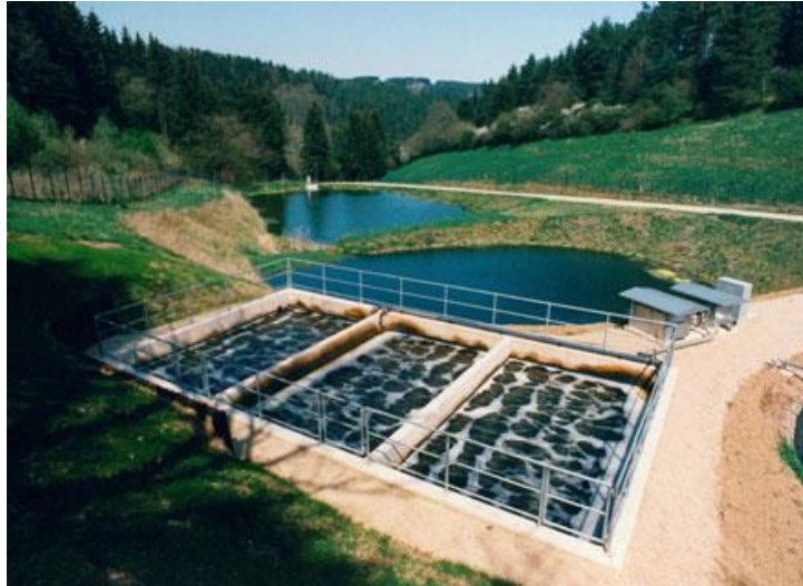
Figure II.3 Système de traitement des eaux usées par lits bactériens (Anonyme 3, 2007).
